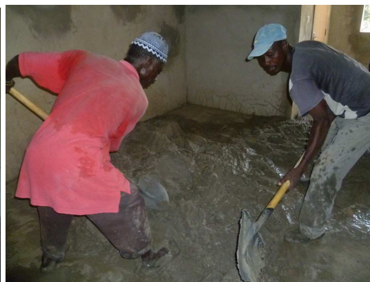
Il faut recouvrir tout le sol d'une couche de ciment : gros travail !
