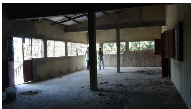
Il reste à recouvrir de ciment le sol de la cour de l'étage
