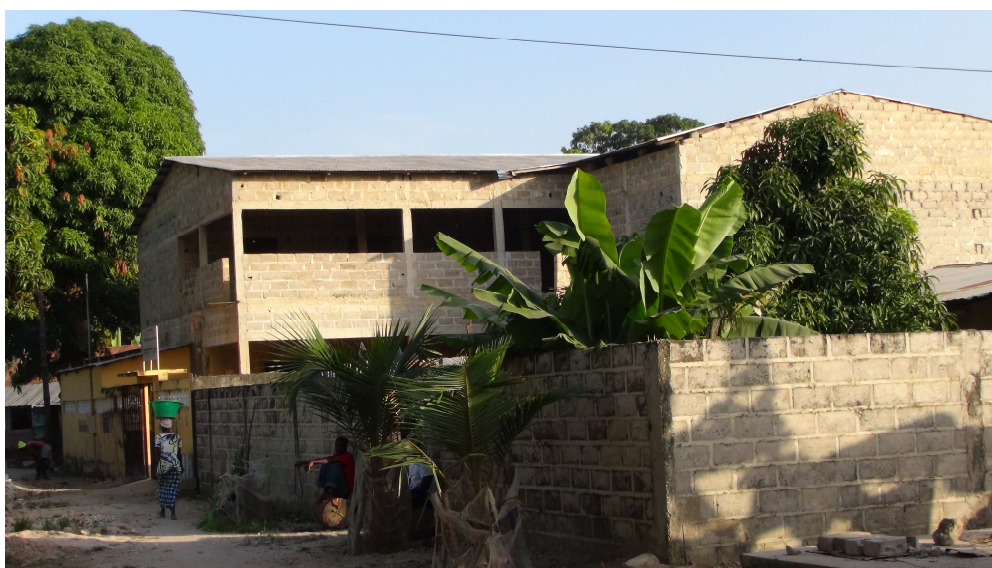
Nov 2015 : une bonne partie du gros-œuvre est réalisée
