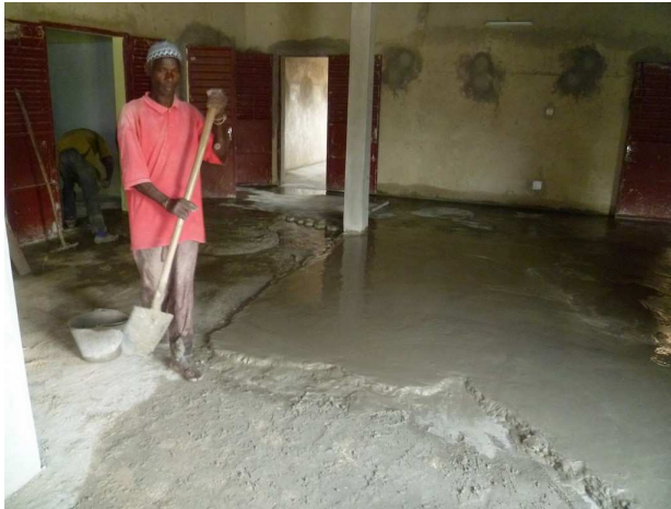
Il faut une bonne couche de ciment
