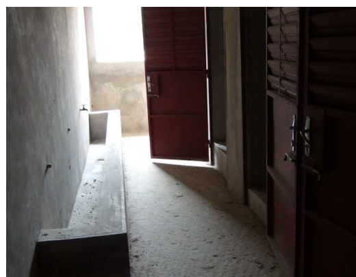
La partie toilettes et lavabos
