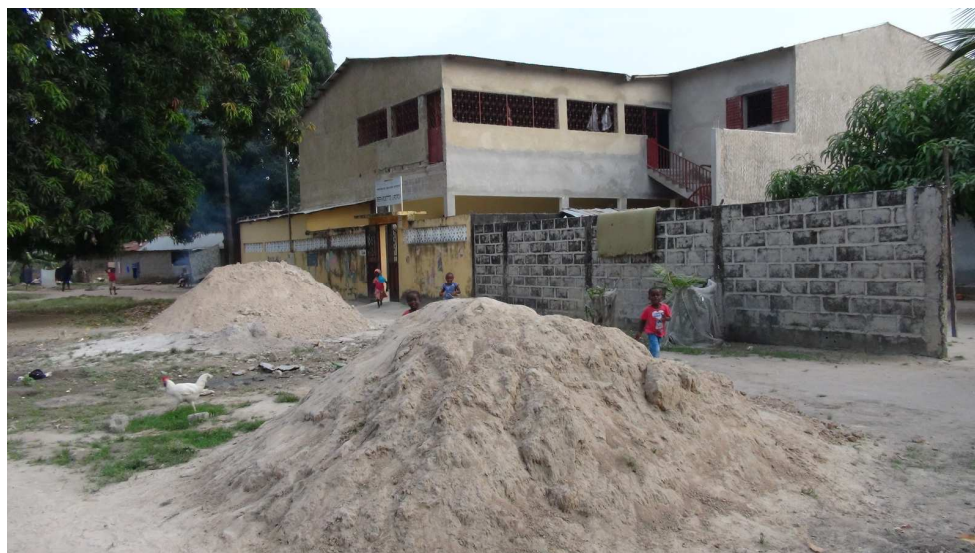
L'école à notre arrivée : un camion de sable pour la suite des travaux
