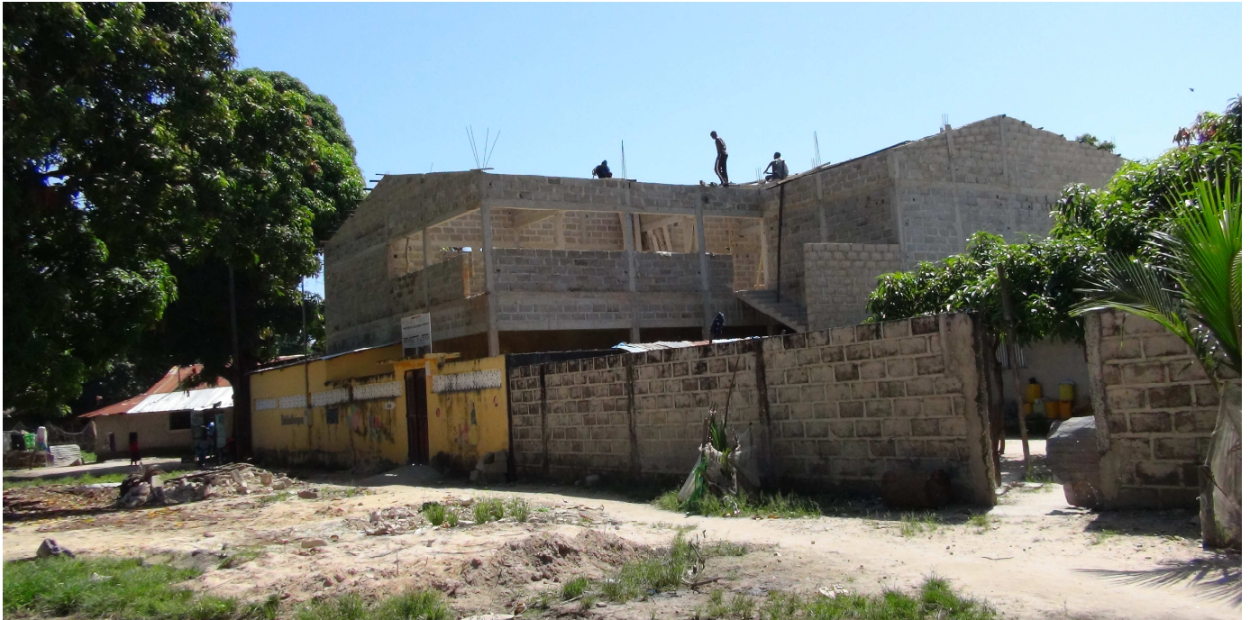
Les travaux d'extension de l'école en novembre 2015
