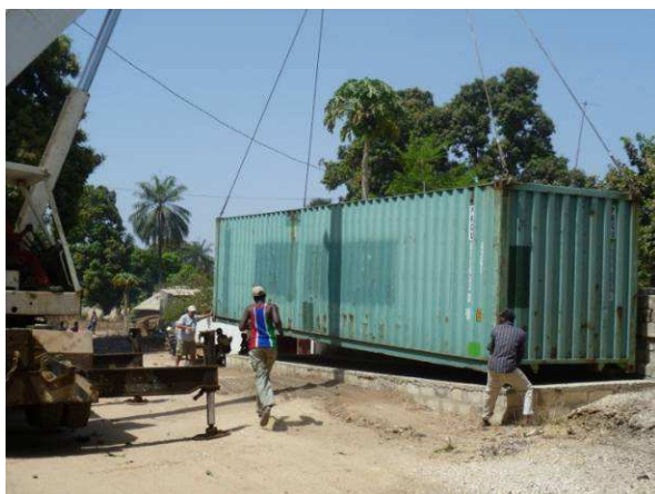
« Le monstre » est presque installé !
