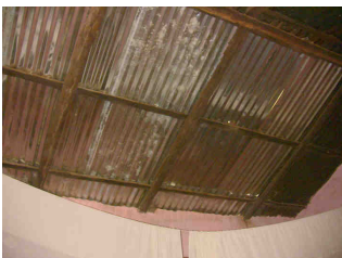
Les tôles remplacées
