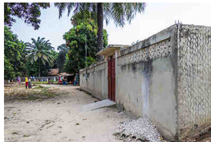
Le mur extérieur et le portail
