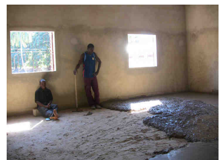
Bonne épaisseur de béton sur le sol
