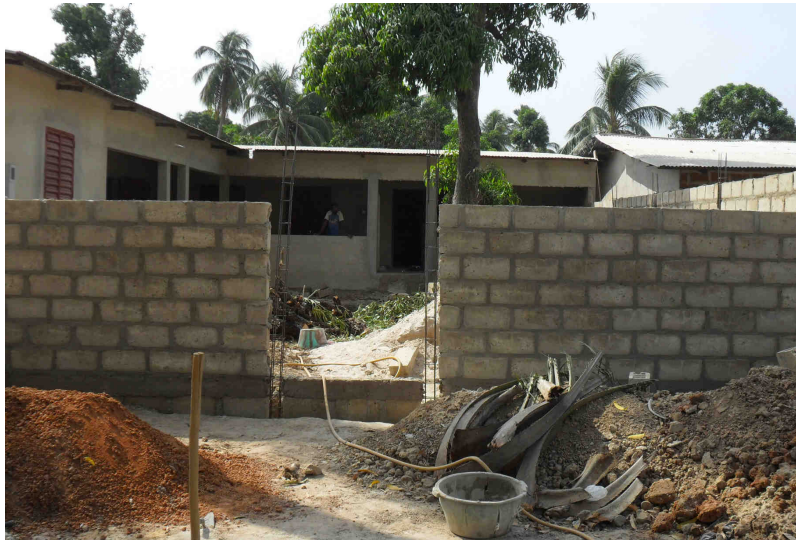
Dernière photo reçue : l'entrée avec le mur d'enceinte
