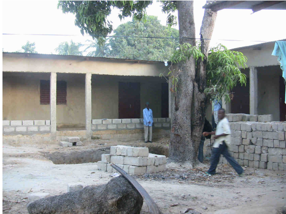
Pendant la construction
